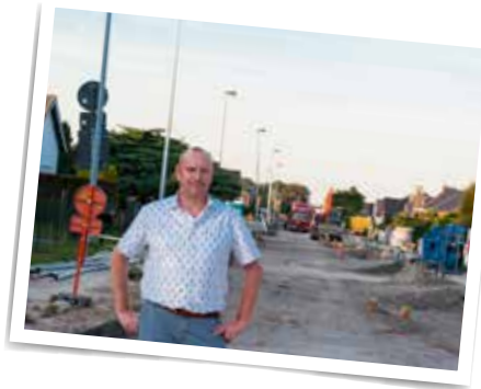
◀ Bestuurslid Mario Schelfhout ziet dat de werken in de Puiveldestraat goed opschieten. De volgende maanden zal keihard gewerkt worden om de wegenwerken in Puivelde tot aan de Nauwstraat aan te pakken.
