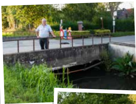
◀ Fractie leider in de gemeenteraad en buurtbewoner Filip Baeyens inspecteert de oude brug aan het kruispunt Leebrugstraat en Leestraat. Deze brug wordt binnenkort vervangen
